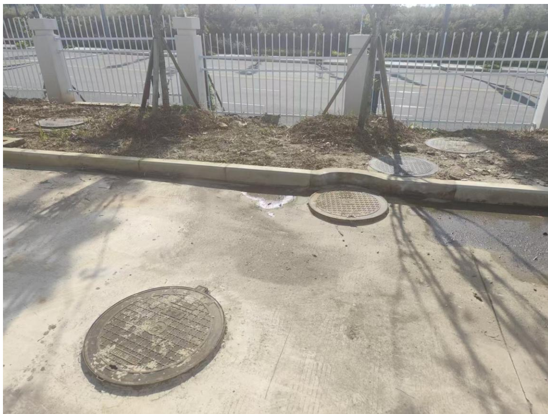
项目现貌（雨水井）
