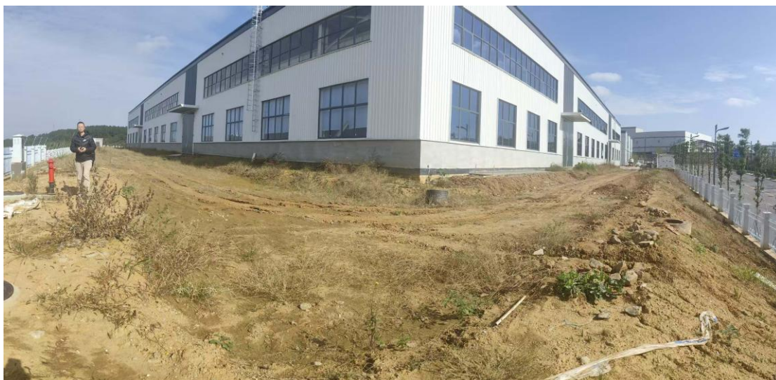
项目现貌（正在进行绿化）
