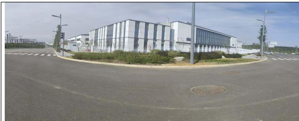
项目厂区现状
