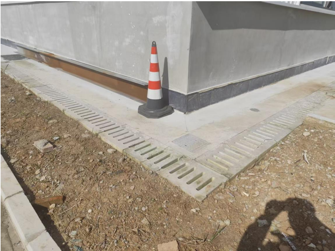
项目现貌（暗沟）
